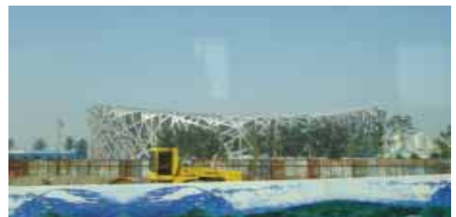
工事中の鳥の巣スタジアム
